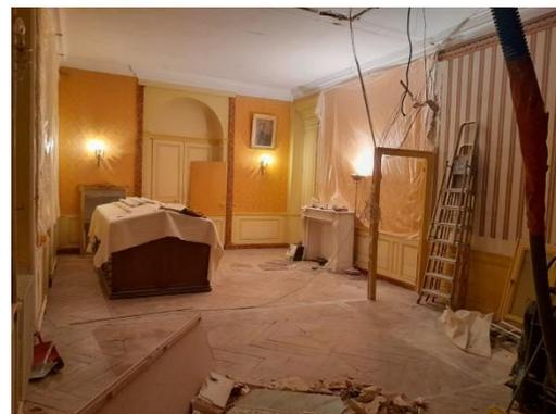
À l'étage : Découverte du mur est de la galerie sur rue, masqué par la cloison d'une salle de bains : trumeau en dessus de porte et arcade du poêle. Démolition en cours des cloisonnements de la galerie sur rue, restituant l'espace initial d'une soixantaine de mètres carrés. Les travaux de démolition ont été effectués par nos soins. 5 tonnes de gravats ont été évacuées.
