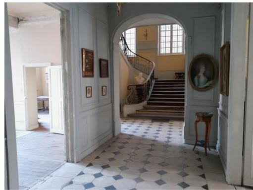
Au rez-de-jardin : suppression du faux-plafond, du parquet flottant posé sur moquette, restauration du plancher de chêne et du réseau électrique.
